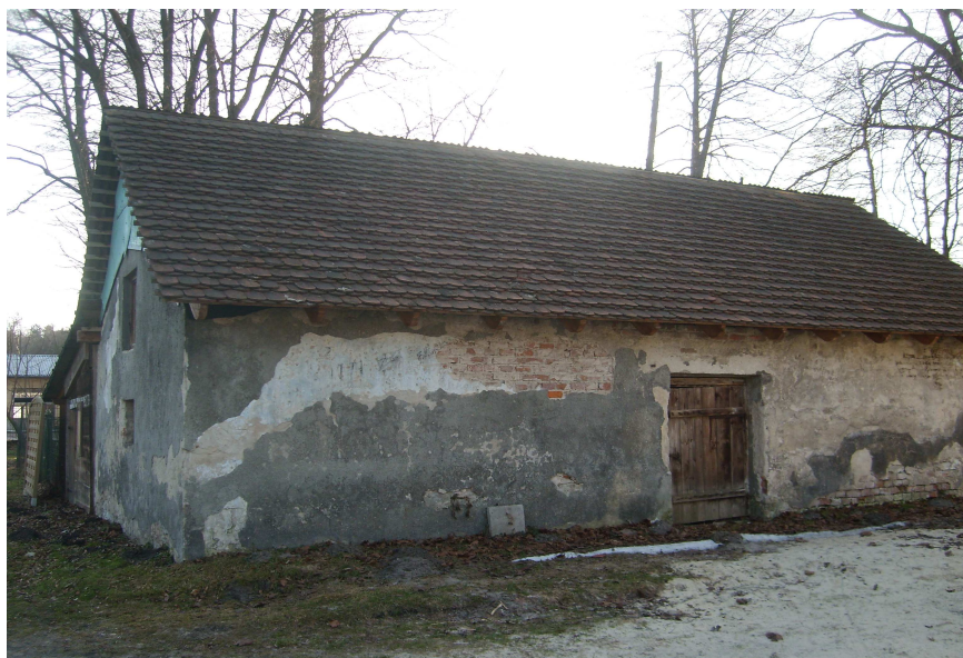
Budynek gospodarczy przy Zespole Szkół Drzewnych i Ochrony Środowiska w Zwierzyńcu, pokryty dwustuletnią dachówką z cegielni w Szostakach
