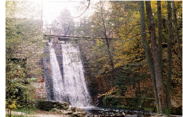
Tama elektrowni wodnej w Górecku Kościelnym
